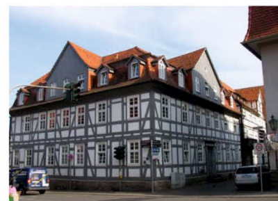
Grebenstein Sanierung und Ausbau
