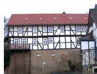
Kassel Sanierung + Modernisierung.
